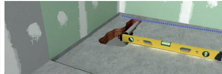
2. Нахил стяжки повинен складати біля 2 відсотків
