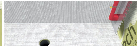
14. Нанесіть плитковий клей на мембрану
