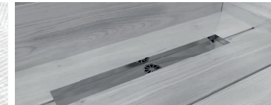
16. Приступайте до облицювання підлоги і стін плиткою
