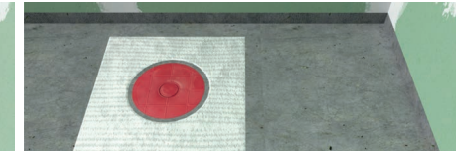
4. За допомогою шпателя з зубом 4x4 мм нанесіть клей для плитки Benfer S1, або S2 класу на поверхню 25x25 см навколо дренажу
