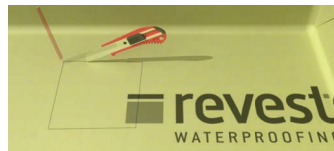
7. Розмітьте та виріжте мембрану з нахлестом не менше 5 см
