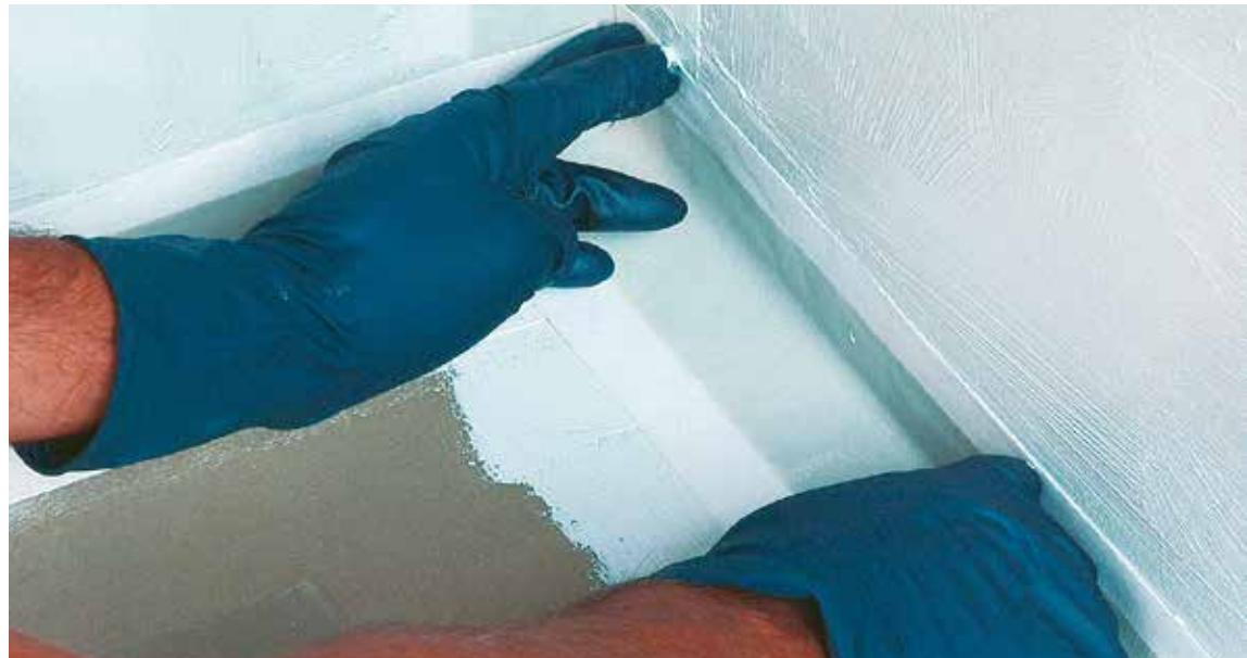
**ТЕХНИЧЕСКИЕ ОСОБЕННОСТИ:** BSWTAPE ECO - водонепроницаемая уплотнительная лента, эластичная, стойкая и стабилизированная; Паропроницаемая и изготовленная из полипропиленовой ткани с эластомерной частью, термопластичная и устойчивая к старению. Это гарантирует быстрое высыхание клеев для плитки и гидроизоляционных продуктов. Устойчивая к сильным и агрессивным веществам.
